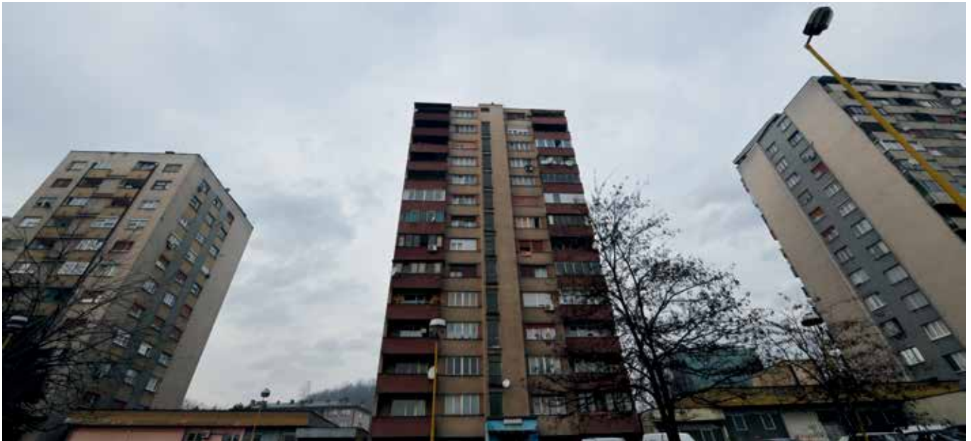
Tuzla (Bosnien & Herzegowina) – Mehrfamilienhäuser mit Fernwärme-Applikation
