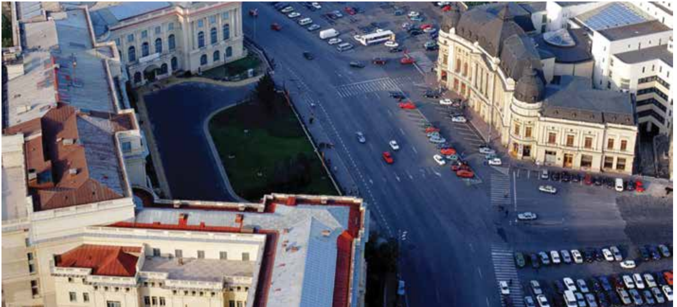
Bukarest (Rumänien) – Mehrfamilienhäuser und Gewerbebauten mit Fernwärmeversorgung
