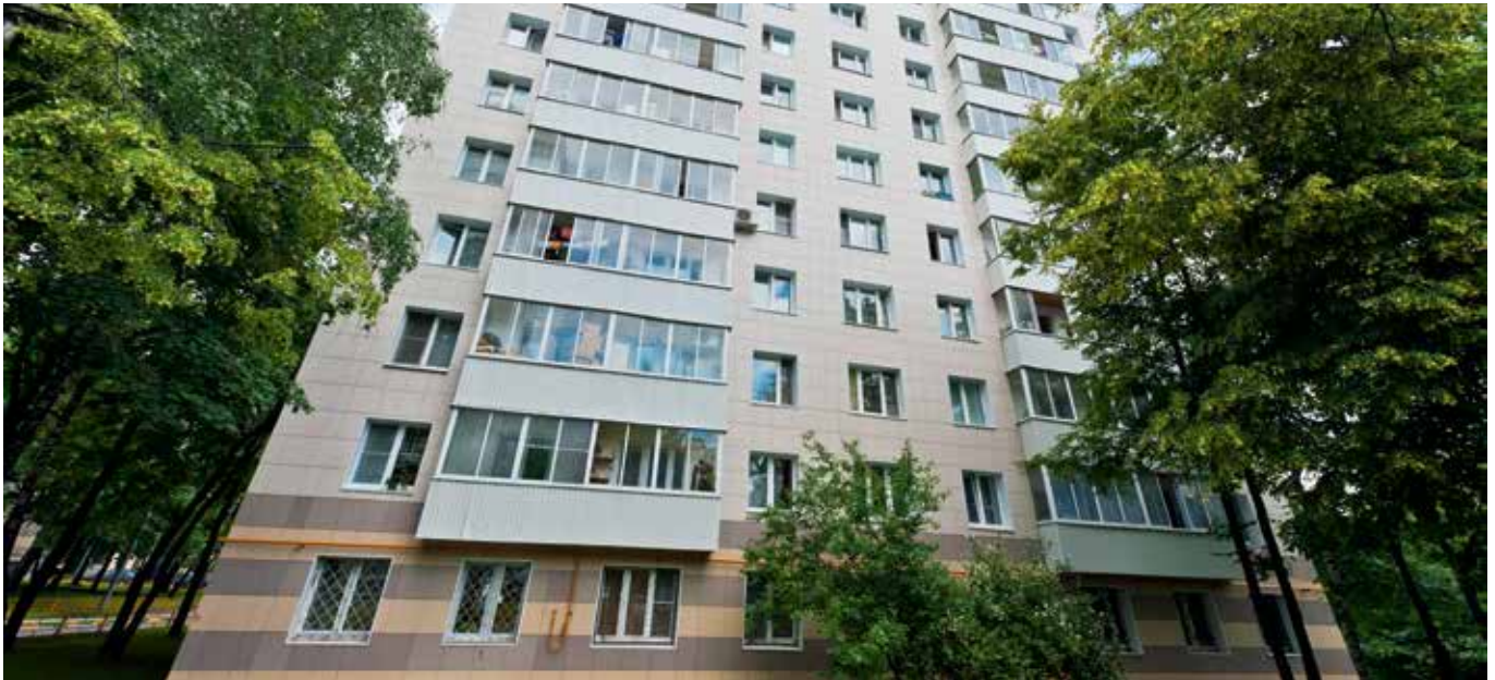
Moskau (Russland) – Mehrfamilienhäuser mit Fernwärme-Applikation
