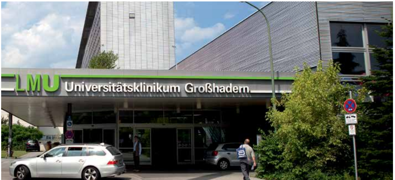
München (Deutschland) – Gewerbebau mit Heizung und TWW-Bereitung
