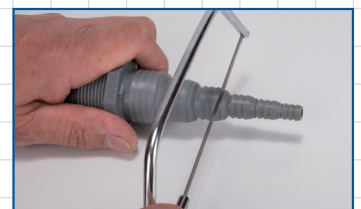
Optimaler Übergang vom Schlauch zum Abflussrohr.
