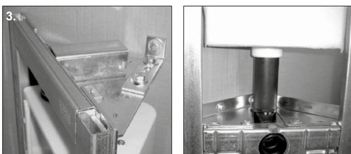
3) Element an der Wand ausrichten, Dübellöcher anzeichnen, bohren und mit beiliegenden Befestigungssätzen verdübeln.
