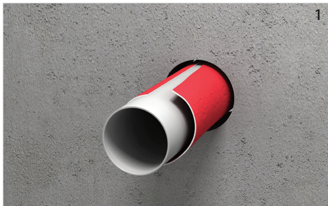
Rohrleitung (ggf. mit Schallschutzschlauch) installieren.
